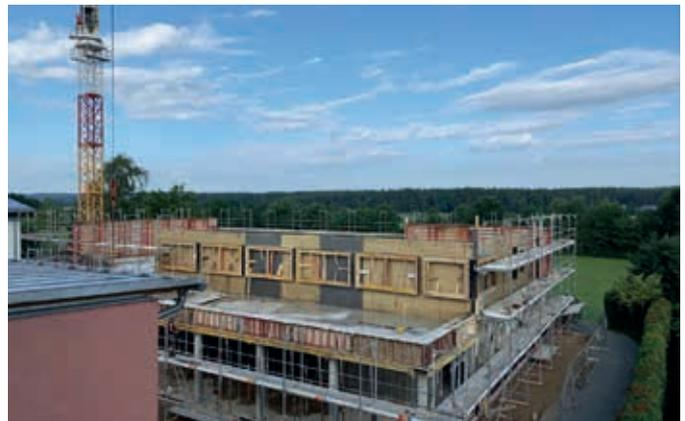
Schalungen für die Außenwände der ersten Etage entstehen.
