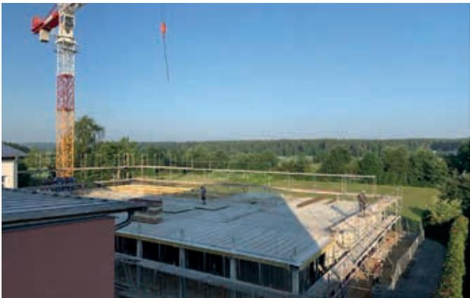
Die Fertigbetondecken des Erdgeschosses werden geliefert.
