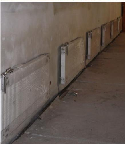
Die Heizungs- und Lüftungskanäle sind fertig verlegt und die Heizkörper zum größten Teil montiert.
