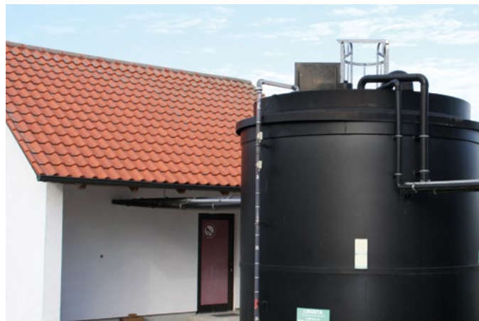
2. Behälter mit roten Phosphatfällmittel (Aluminium und Eisensalze) - diese werden in das Haus zu den Pumpen geführt.
