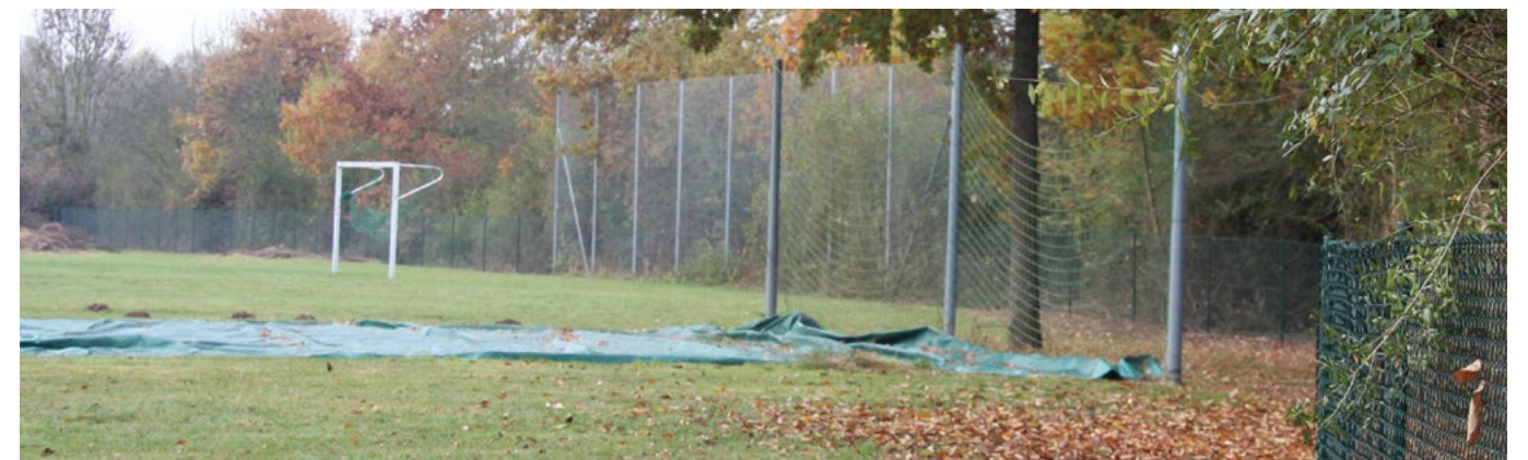
In viereinhalb Tagen wurden 220 Meter grüner Maschendrahtzaun aufgestellt.
