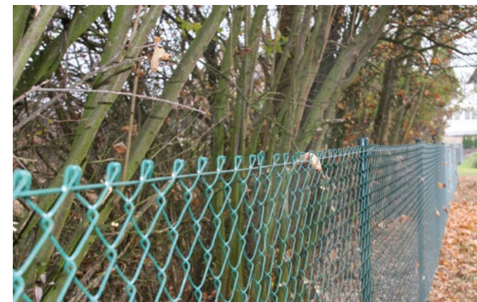
Nord- und Westseite des Geländes sind nun eingezäunt.
