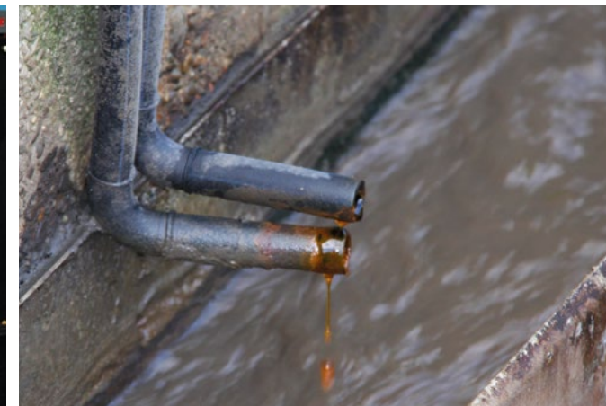
4. Rund 22 Tonnen werden dem Abwasser pro Jahr zugeführt, das zuvor im Denitrifikationsbecken vom Nitrat befreit wurde.
