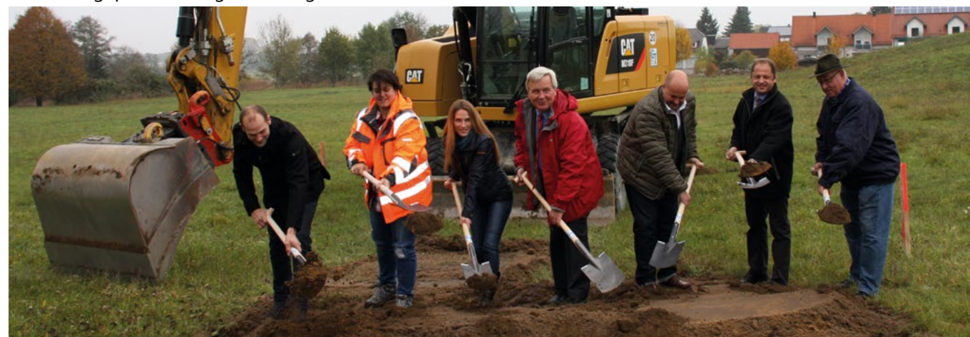
Gruppenbild (von links nach rechts): Herr Geltl (Fa. Geltl Tiefbau GmbH), Frau Loewe (Fa. Geltl Tiefbau GmbH), Frau Parchatka (Bauamt VG Siegenburg), Herr Dr. Bergermeister (1. Bürgermeister), Herr Wöhrmann (Ingenieurbüro Wöhrmann), Herr Bergermeister (Geschäftsleiter VG Siegenburg), Herr Ettengruber (3. Bürgermeister)
