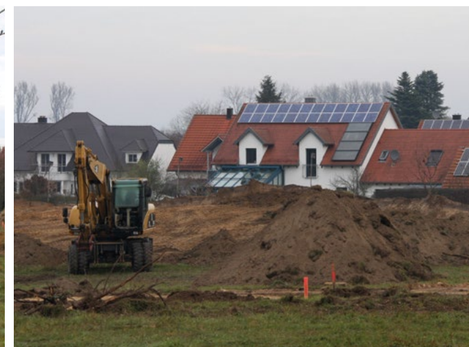
Bereits eine Woche nach dem Spatenstich: Hügelandschaft.
