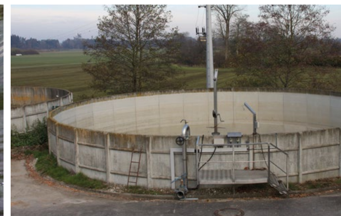
8. Nachdem der Klärschlamm entwässert wurde, kann dieser als Dünger für die Felder verwendet werden.
