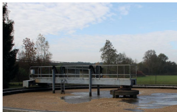
5. Im Belebungsbecken werden Bakterien mit Sauerstoff aktiviert.
