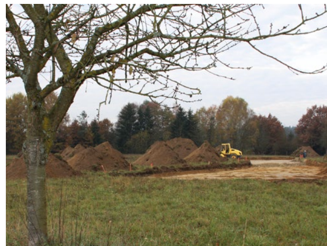
Besonderheit: Errichtung einer provisorischen Baustraße.
