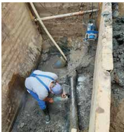
Die Leitung wird gekappt
