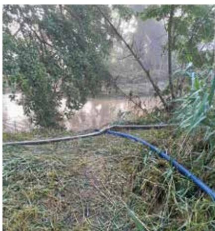
Anstückelung der Behelfsleitung
