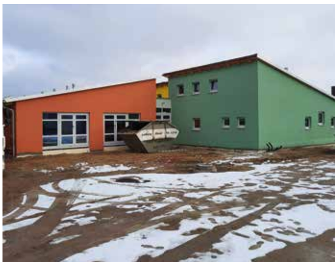
Der Bau des Kommunalen Kindergartens schreitet voran.
