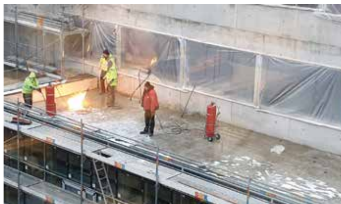
Auch die Dacharbeiten über der Mensa gingen im Januar und Februar wieder weiter.
