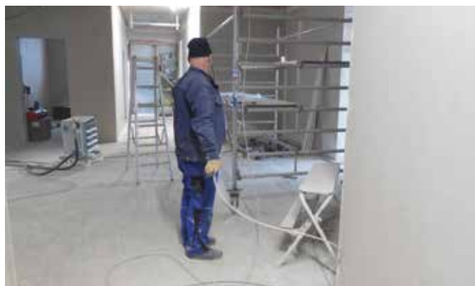
Dank der Winterbauheizung konnte viele Gewerke im Innenbereich vorangetrieben werden.
