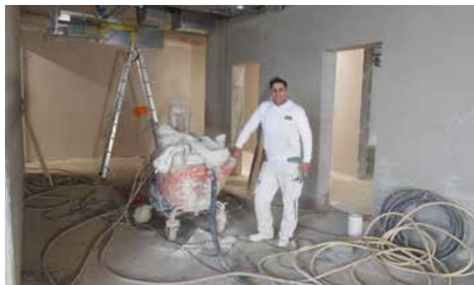
Und auch die Putzarbeiten der Innenwände konnten im Februar durchgeführt werden.
