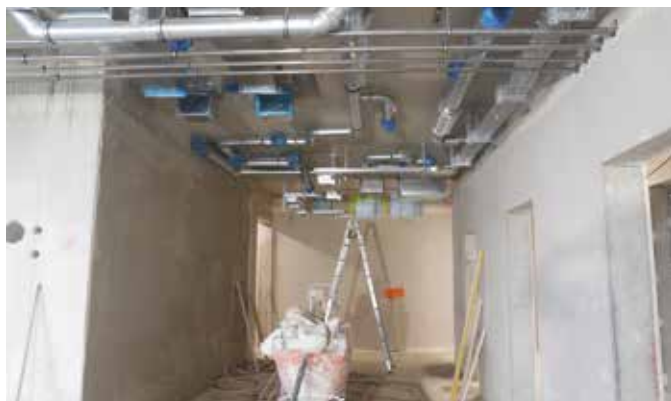
Die Installation der Heizungs- und Klimatechnik wurde begonnen.
