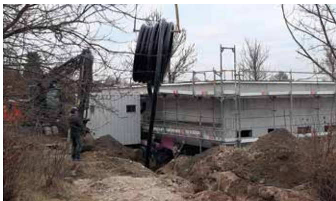
Die Fernwärmeleitung wurde vom Heizhaus zum Erweiterungsbau verlegt.
