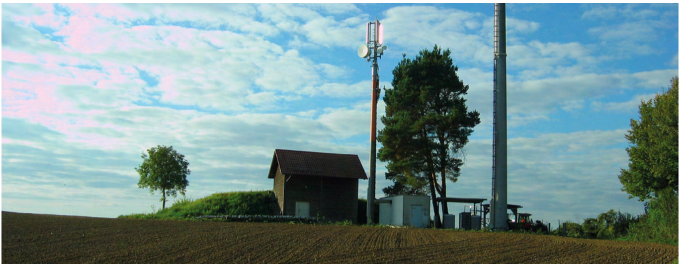
Ansicht von außen (der eigentliche Wasserspeicher befindet sich unter der Erde)
