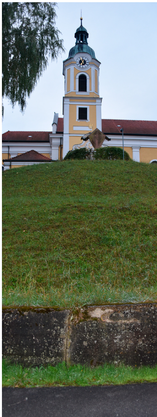
Sanierung der Kirchbergmauer
