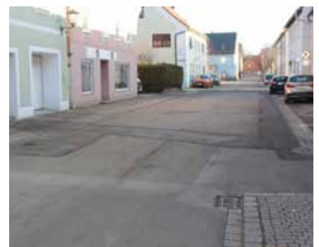
In der Herrenstraße wird der Kanal saniert.
