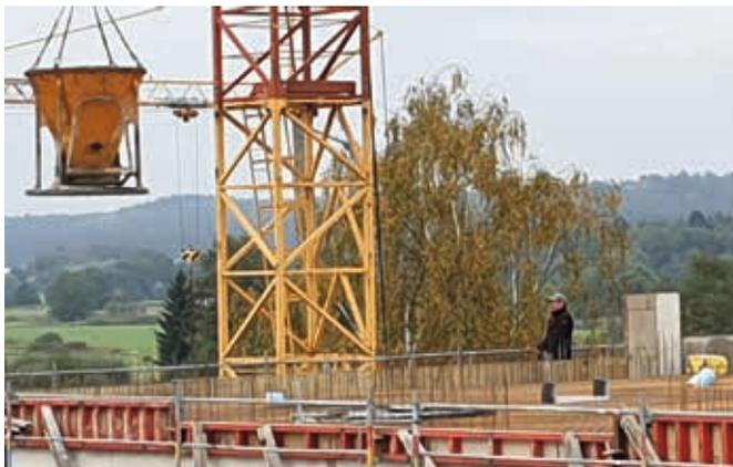
Die Schalungen für die Decke des Hauptgebäudes wurden montiert.
