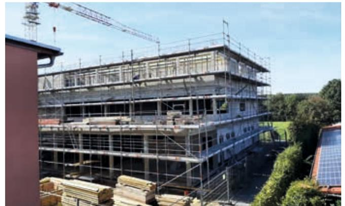
Es wurden die Außenwände betoniert und das Gerüst erhöht.
