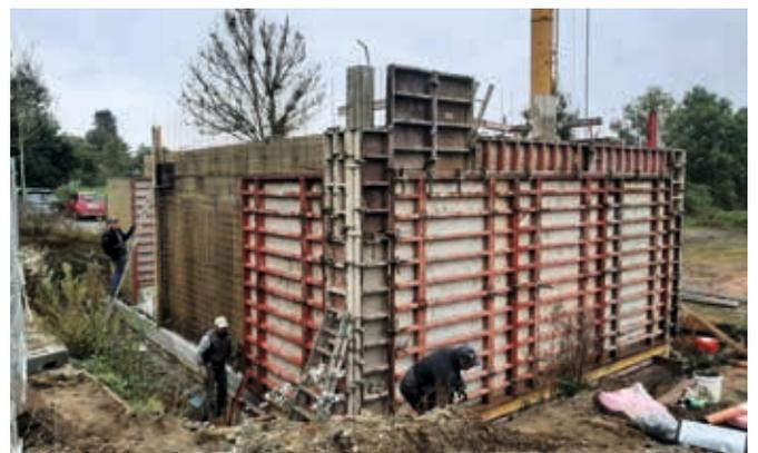
Auch beim Heizhaus werden bereits die Wände eingeschalt.
