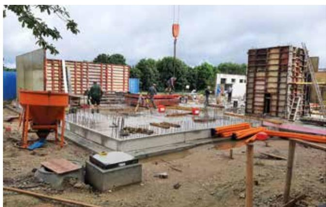
Die Schalungen für die ersten Wände werden montiert.
