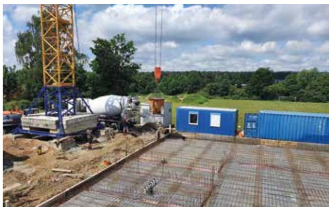
Der Baustahl für die Bodenplatte wurde eingebracht.
