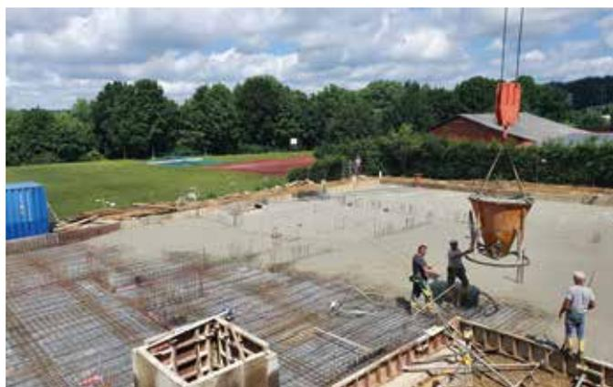
Bereits wenige Tage darauf wurde die Bodenplatte betoniert.
