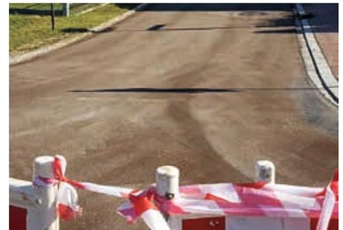
fehlte noch die Feinschicht. Nachdem alle Bau-parzellen in dem Baugebiet bebaut sind und eine Verlegung von Glasfaserleitungen von den Netzbetreibern ausgeschlossen wurde, ist nunmehr die Feinschicht aufgebracht worden. Im anschließenden Baugebiet Hochstetterfeld Ost wird die Feinschicht voraussichtlich in drei Jahren gefertigt. Die Kosten für diese Feinschicht betragen rund 67.000 €.
