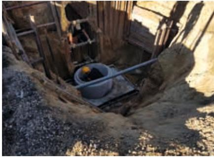
aufgelöst. Aus diesem Grund musste der Kanal bis zu den unbeschädigten Stellen freigelegt und neu aufgebaut werden. Eine Reparatur war unumgänglich. Wäre diese Maßnahme unterblieben, wäre in einigen Jahren die Straße großflächig eingebrochen. Die Kosten dafür betragen 40.000 €.
