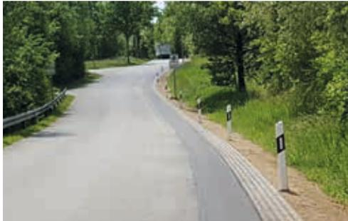
Aus diesem Grund wurde dieser Bereich mit einer massiven Bewehrung aus Granitsteinen in einem Betonbett stabilisiert. Weiterhin wurde der Seitenstreifen bei der Auffahrt zum Gewerbegebiet Egelsee auf der Seite zur A93 befestigt. Dieser Seitenstreifen wurde bei Starkregen immer ausgespült und LKW's nutzten den Streifen zum Parken. Deshalb sah diese Seite immer ungepflegt aus.
