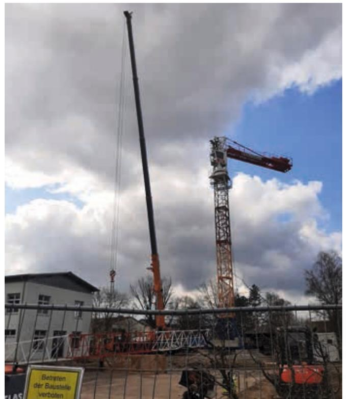
Mit einem großen Kran wird der Ausleger des Baukrans angehoben und montiert.
