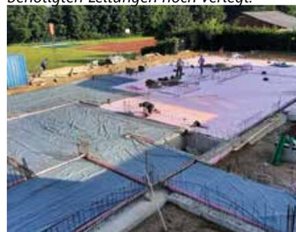
Die wasser- und druckbeständige Perimeterdämmung
