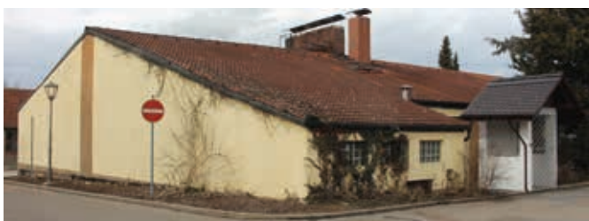
Hier soll ein zweigeschoßiges Gebäude entstehen.
