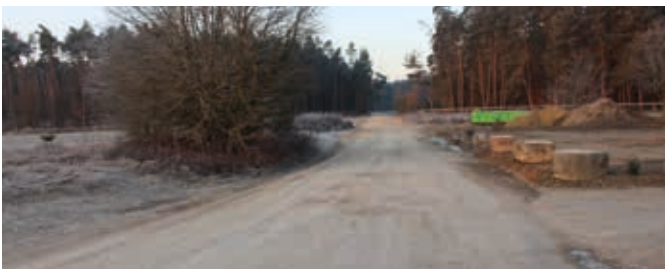
Der Weg zum Funkhaus soll geteert werden.
