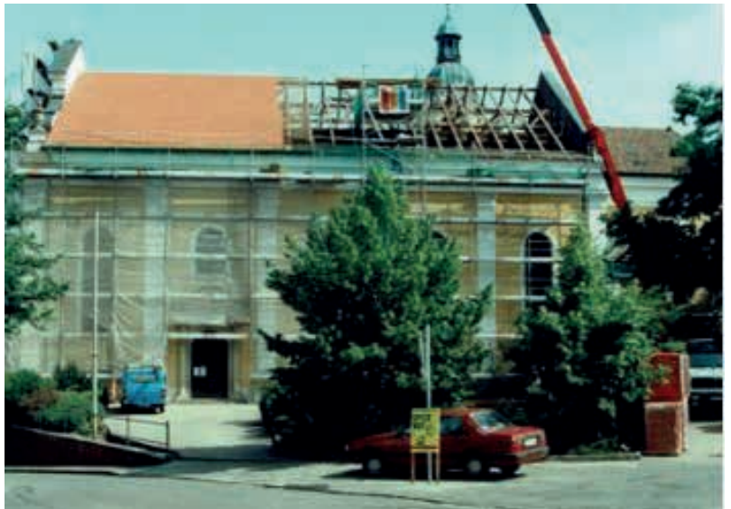
Kirchenrenovierung Ansicht von außen
