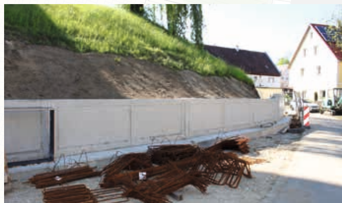
Ein großes Stück Stützmauer steht bereits.
