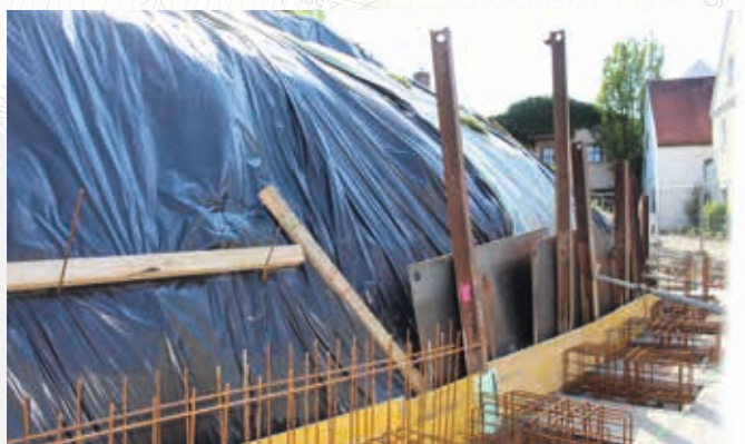
Der Hang wurde mit Folie abgedeckt.
