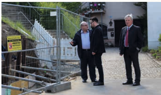
Hans Ertlmeier, Pfarrer Franz Becher und Bürgermeister Dr. Johann Bergermeier an der Baustelle.
