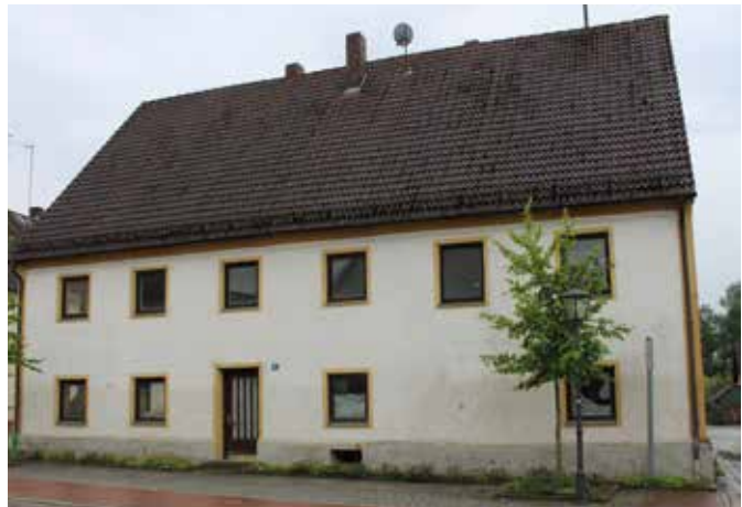
Das sog. „Eisenbauernhaus“ in der Ingolstädter Straße: Abbruch und Neubau oder doch eine Sanierung?
