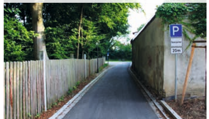
Die Zufahrt zur Hofmark nach der Neugestaltung
