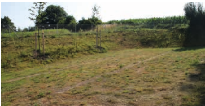
Der Friedhof wurde um diese Fläche erweitert und mit Fundamenten ausgestattet.
