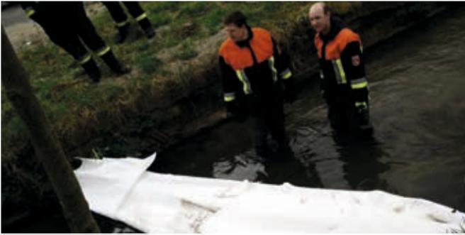
**17./19.04.2015:** Öl auf dem Siegbach; es wurden insgesamt 6 Ölsperren eingebaut, damit dass Öl aufgefangen und entfernt werden konnte.
