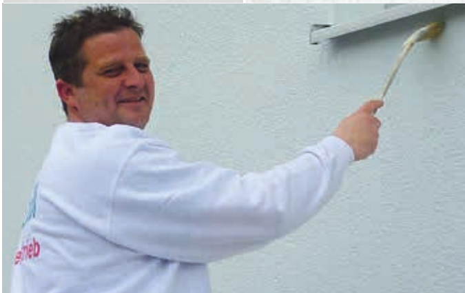
Kurt Graßl bei den letzten Malerarbeiten an den Außenwänden der Herzog-Albrecht-Schule.
