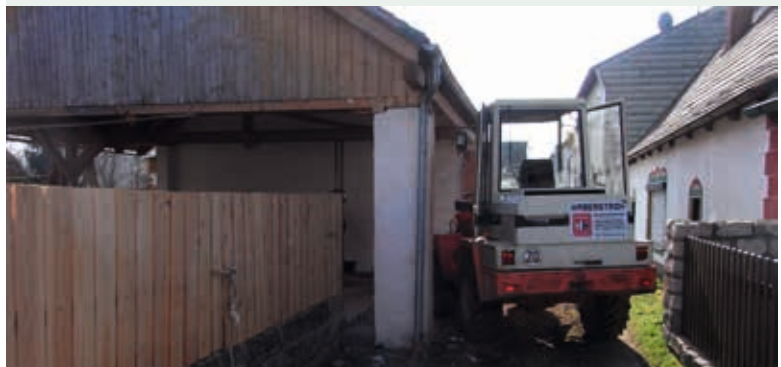
Die Firma Haberstroh bei den Bauarbeiten an der Engstelle in der Bindergasse.
