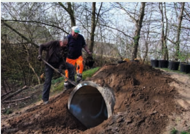
Die Bauhofarbeiter beim Freilegen des Betonrohres am Turnerhölzl.
