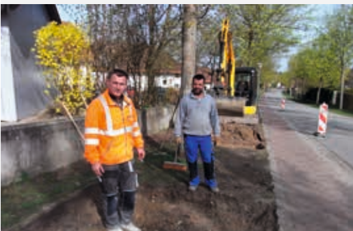
Die Bauarbeiten für die neuen Schotterrasenparkplätze sind bereits im vollen Gange. Foto: Dr. Bergermeier
