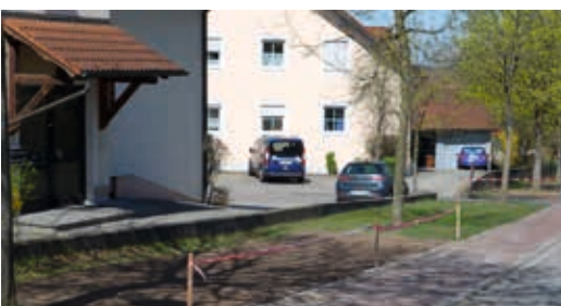
An der Landshuter Straße entstehen durch das Aufschütten von Humus und Schotter neue Rasenstellflächen. Foto: Christoph Schmal
