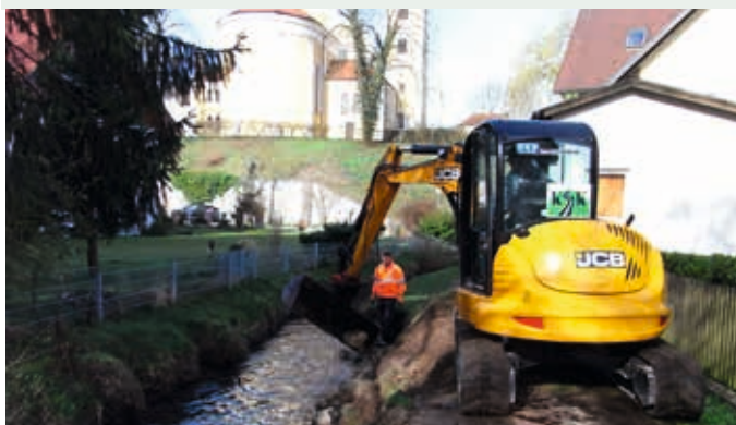
Die Arbeiten der Fachfirma an der Bachmauer an der Sieg.
