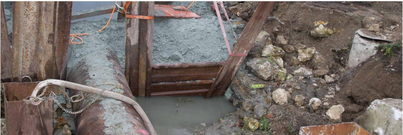
Ein weiterer Bauabschnitt für die Sanierung des Siegbaches wurde in Angriff genommen: Der Lückenschluss der Bachmauer von der Metzgerei Present bis unter die Siegbachbrücke konnte beginnen. Um hier die notwendigen Betonarbeiten durchführen zu können, wurde ein großes Stahlrohr zur Abführung des Siegbaches eingezogen. Erst dann konnte die neue Stützmauer betoniert werden.
